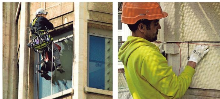
De werken gebeurden op grote hoogte. Er werd 18 kilometer kabel in de voegen geplaatst. Foto's Laenen
