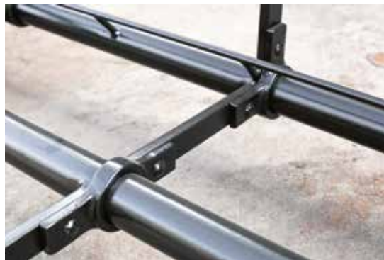
De geklonken en nat gelakte structuur met toevoeging van de dunne volstalen staafjes om het staalnet aan op te hangen (foto J. Umans)
