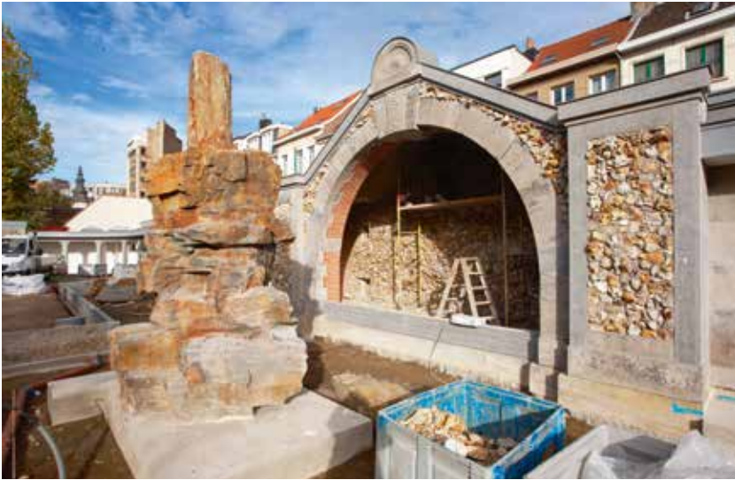
De Roofvogelvolière in aanbouw (foto O. Pauwels)
