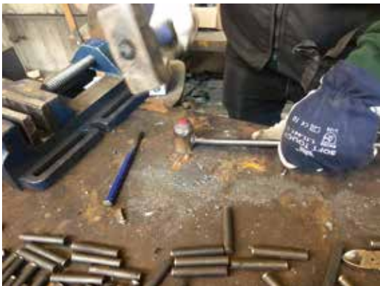
In het atelier vervaardigde klinknagels (foto G. Laeremans)
