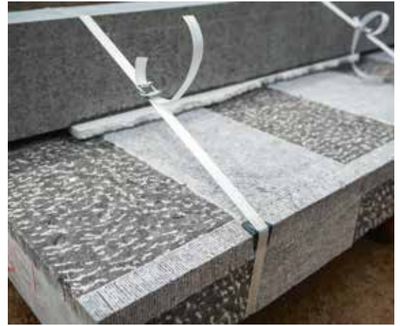
Nieuwe steen met fijne frijnslag en ingekapte gebouchardeerde delen (foto O. Pauwels)
