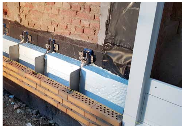
De aanzet van de nieuwe geïsoleerde spouwmuur (foto Patine)
