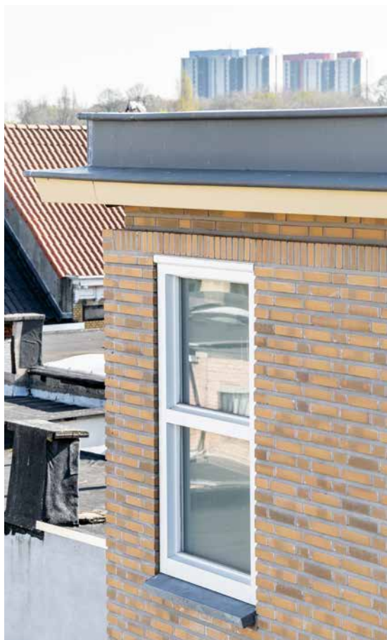
Detail van de vernieuwde kroonlijsten aan de patio's (foto Lucid)
